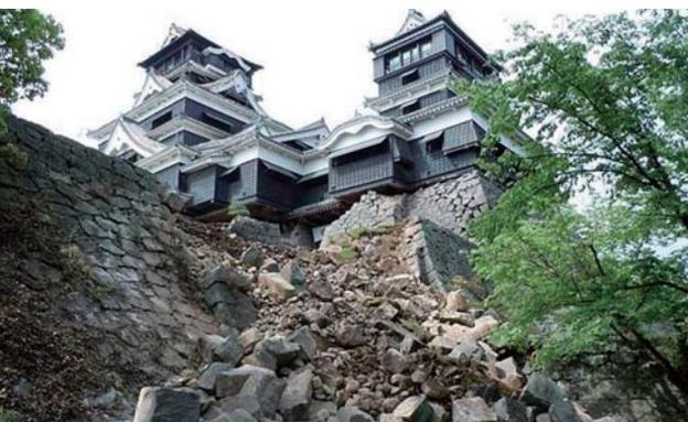
写真1 崩落した熊本城の石垣(熊本市中心区)
