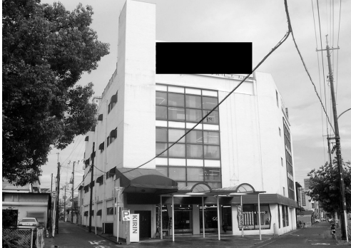
違反を指摘された防火対象物
