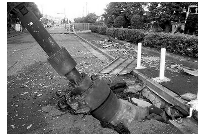
図3 公道に突き刺さったオートクレーブ
