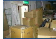
写真6 4階非常口付近 4階平面図の23の位置から4階南側非常口を見分する。なお、写真は明るさを補正している。非常口手前には段ボール箱が16個積み上げら...
