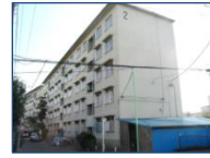
写真3 建物全景(付近図1の位置) 建物の全景を建物の南東側から俯瞰する。付近図では1の位置である。建物は鉄骨鉄筋コンクリート造で、5階建て、出入口は開放型階段に面した各住戸の出入口につながっている。
